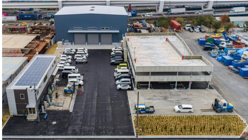
社屋に設置した太陽光パネル(本社)
